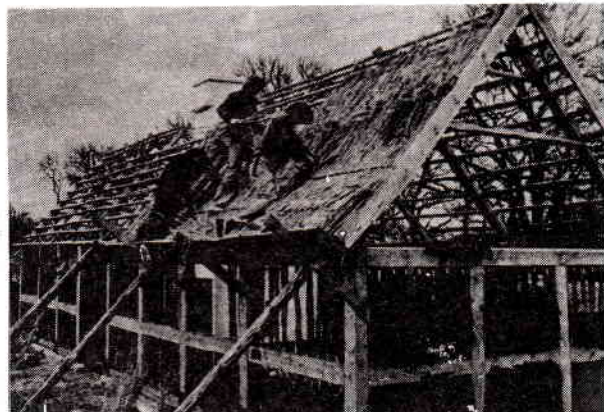
Rekonstrukce domu z doby železné.
