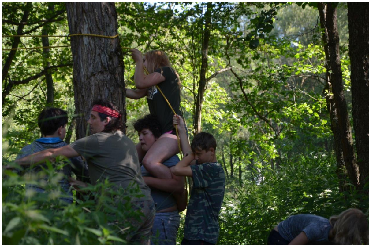
Stavba lanové lávky (autor: Ilona Kaletová)
