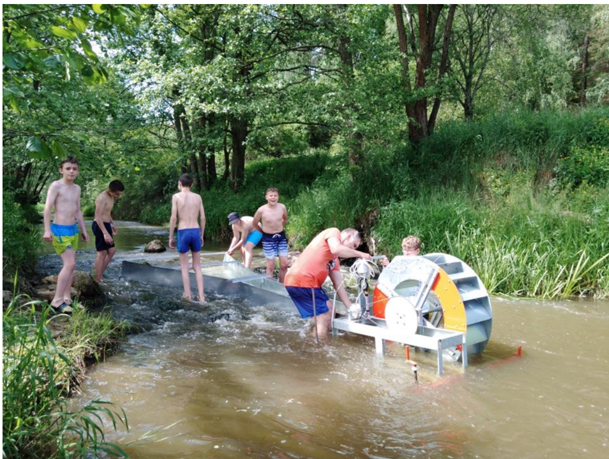
Usazení elektřárničky v potoce.
